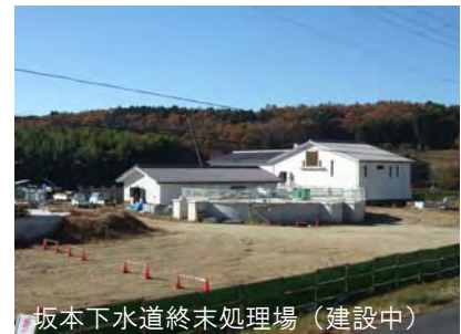
坂本下水道終末処理場（建設中）
